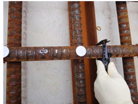
鉄筋径の確認状況
