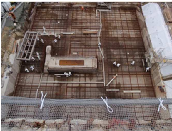
基礎スラブ配筋状況全景
