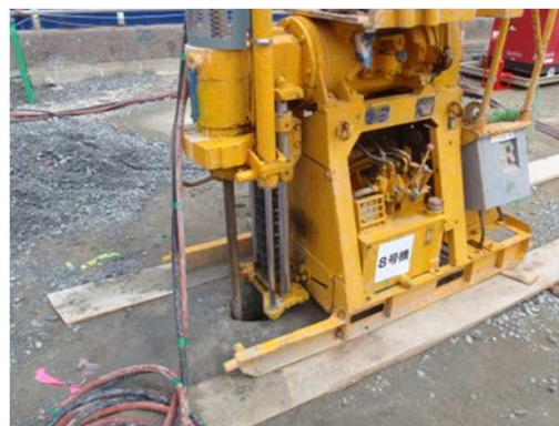
地盤改良状況
