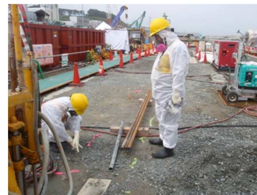
薬液注入間隔の確認
