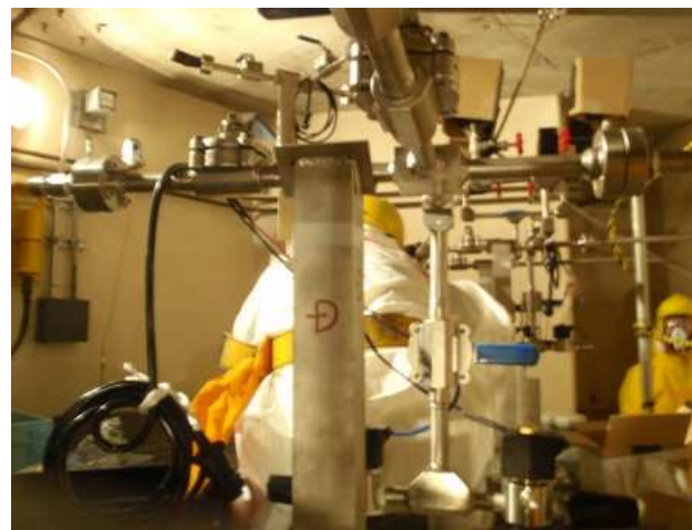
新規隔離弁の取付け作業
