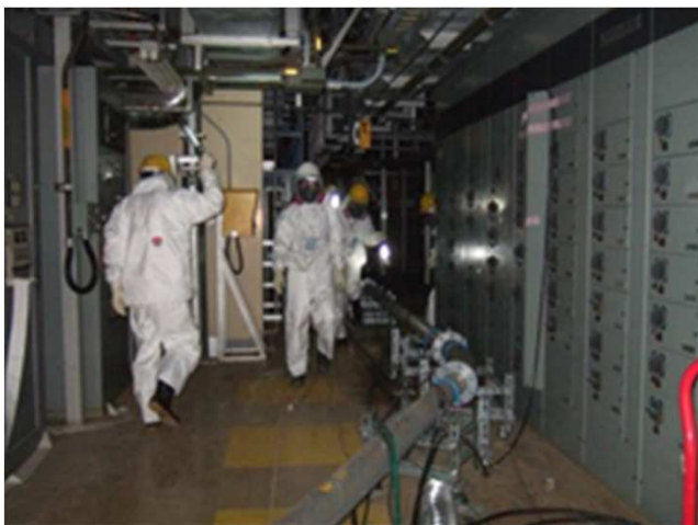
原子炉建屋入り口付近、前方右側側に目的のTIP室がある。雰囲気線量は5~10mSv/h
