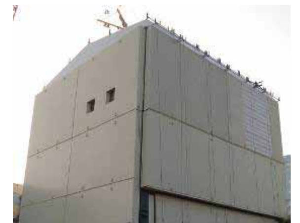
1号機原子炉建屋カバ-設置
