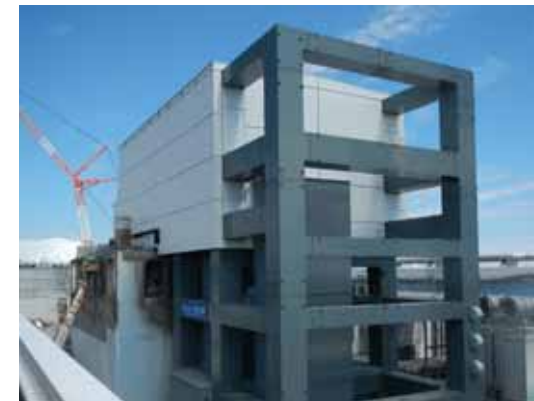
燃料取り出し用カバー外壁設置
