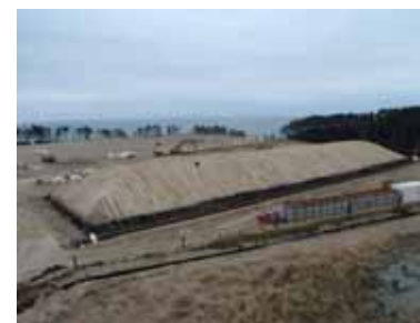
1槽目の状況 (3/27撮影)
