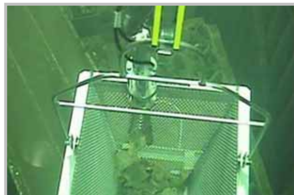
落下がれき撤去作業 撮影日：2013年9月下旬
