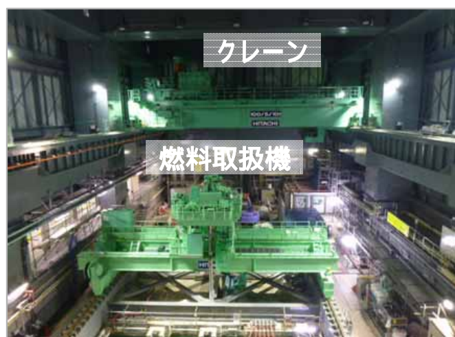
燃料取り出し用カバー内部
