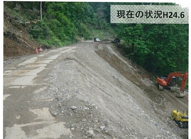
盛土により、片側一車線を確保して、工事用車両が通行できるようになりました
