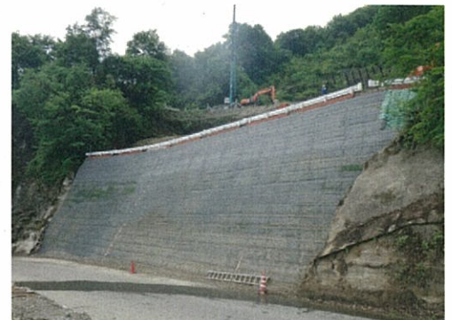
高さH=12mの擁壁が積み上がりました
