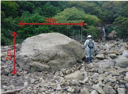
スノーシェッドの上に流出した岩塊
