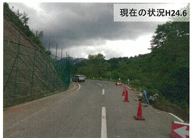
土砂を撤去し、法面に金網を張って、一車線を確保しました。今後は吹付砕工を実施します。
