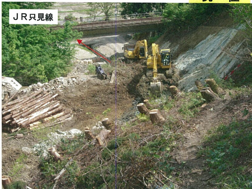
砂防堰堤工事を行うための仮設道路工事中(進捗率約7%)
