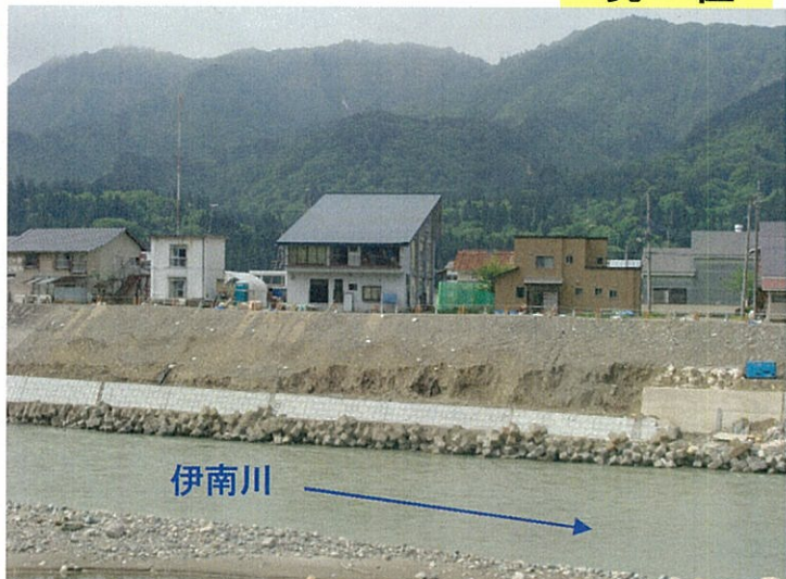
護岸工施工中(進捗率約30%)(平成24年5月29日撮影)
