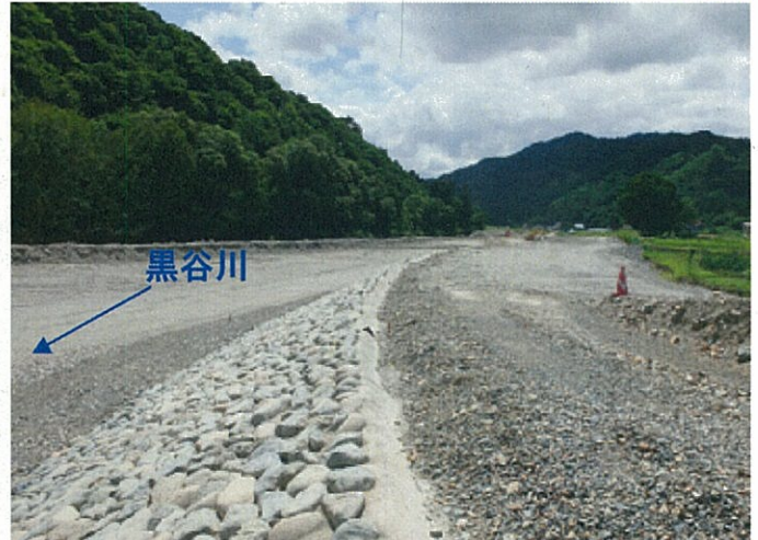
自然石護岸工施工中(平成24年8月8日撮影)
