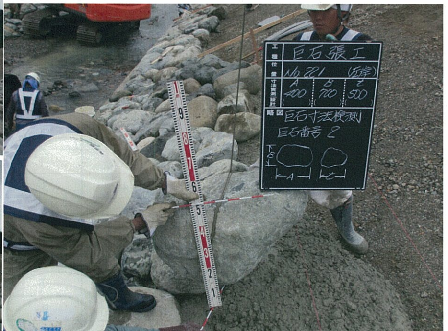
試験施工(石張りの勉強会)＜自然石の直径は約40～60cmを採用＞(平成24年6月21日撮影)
