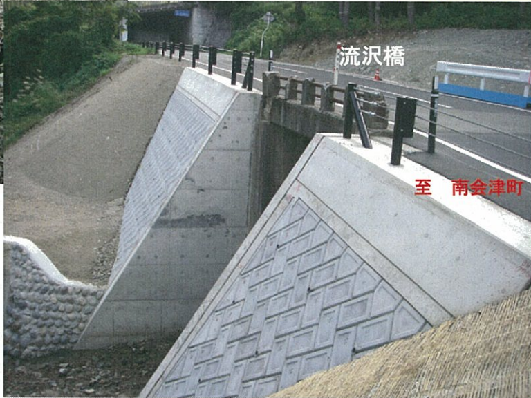
国道352号：深瀬スノーシェッド近くの流沢橋 付近が工事完了（平成24年8月31日撮影）
