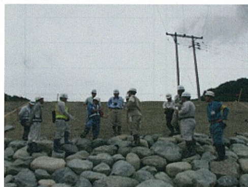
試験施工(石張りの勉強会)＜自然石の直径は約40～60cmを採用＞(平成24年6月21日撮影)
