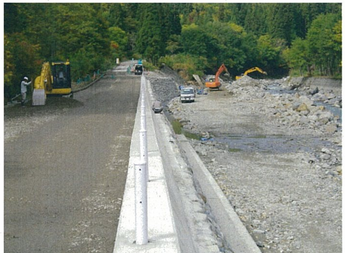
5 道路路盤工施工中(平成24年10月25日撮影)
