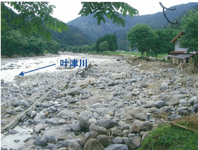
叶津川:只見町大字叶津地内(3工区)
