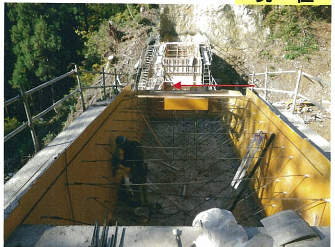
本堰の側面(平成24年10月25日撮影)
