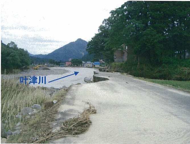
叶津川:只見町大字叶津地内(1工区)
