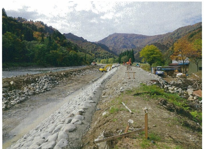
自然石護岸工施工中(平成24年10月25日撮影)
