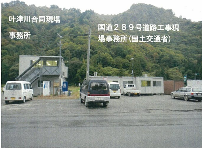
現場事務所(平成24年10月18日撮影)
