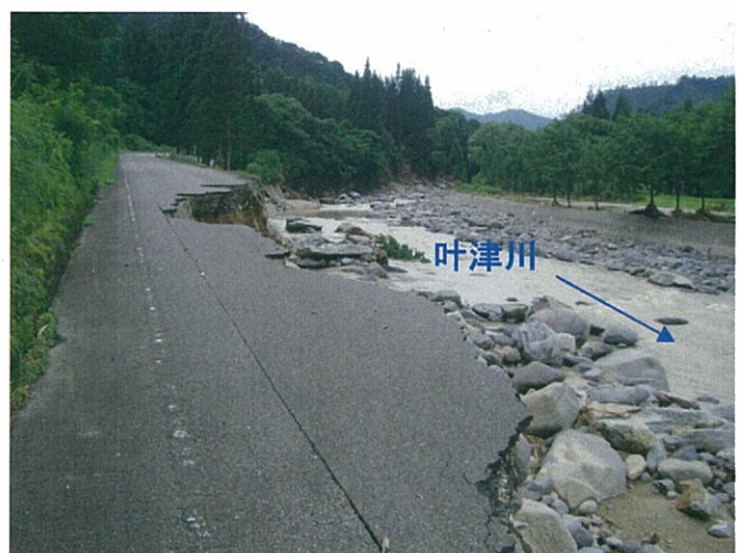
叶津川:只見町大字叶津地内(入叶津工区:単災)
