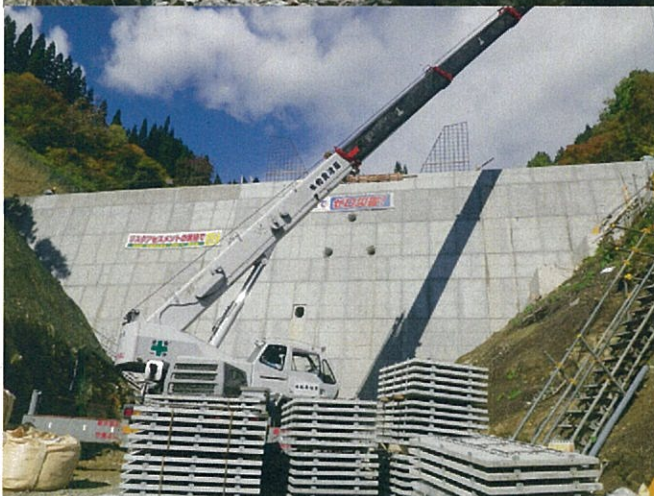
本堰の正面(大型残存型砕工法:治山ダムの下流に嵩上げ)
