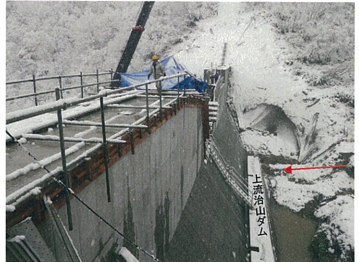
本堤左岸コンクリート打設完了(H=14.5m、L=58.0m)
