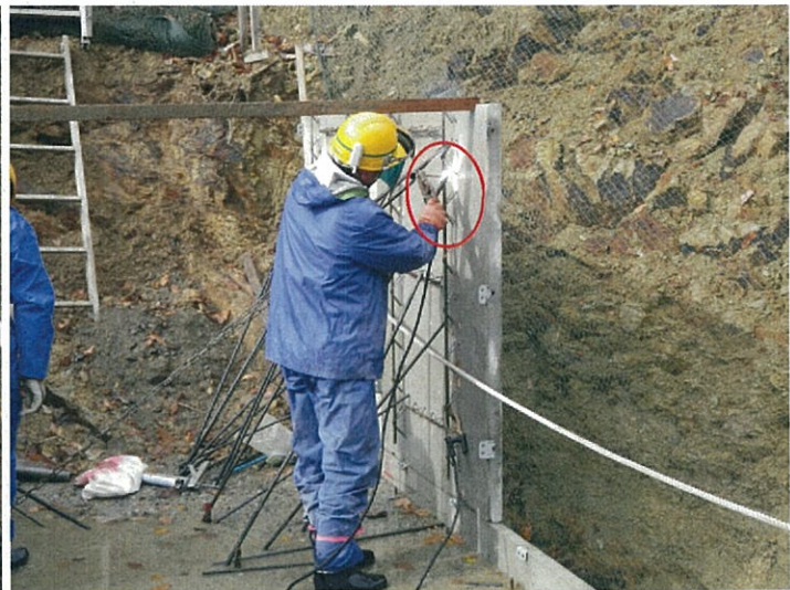
⑥支保工用セパ鉄筋の溶接 (平成24年11月14日撮影)
