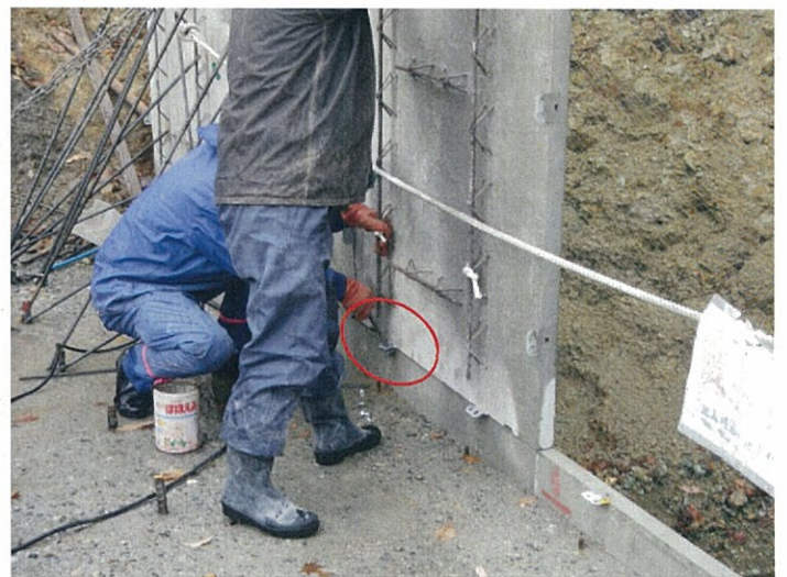
④接続用ジベルの一方の穴によるシノー等での壁面調整 (平成24年11月14日撮影)
