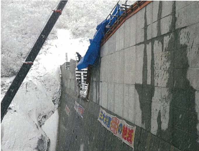
本堤左岸コンクリート打設完了(平成24年11月27日撮影)
