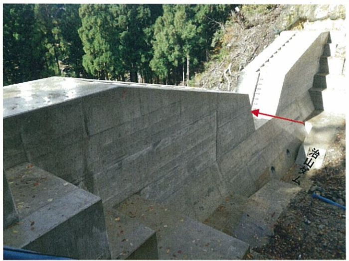
沼頭沢（只見町大字黒沢地内）砂防堰堤(H=10.0m,L=33.5m)の本堤コンクリート打設完了（平成24年11月14日撮影）
