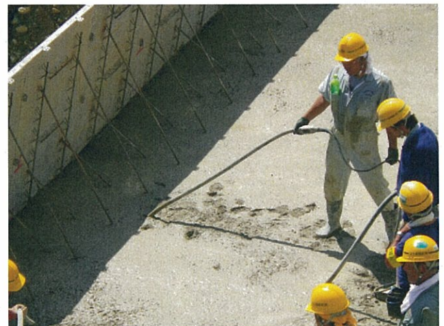
4 大型残存型枠の内部(平成24年8月31日撮影)
