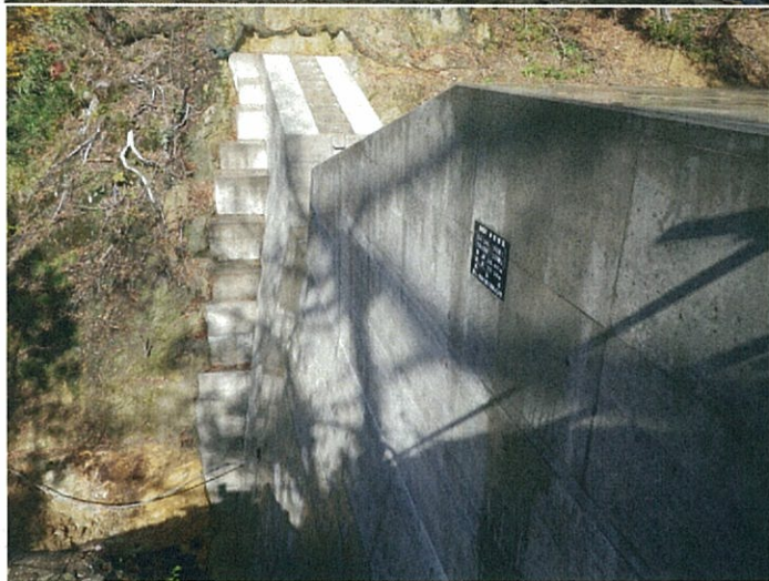
沼頭沢（只見町大字黒沢地内）砂防堰堤(H=10.0m,L=33.5m)の本堤コンクリート打設完了（平成24年11月14日撮影）
