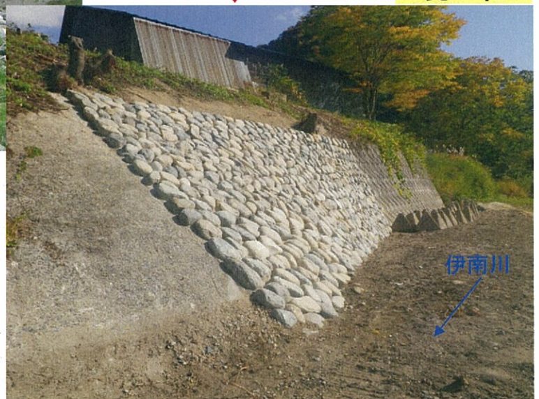
自然石護岸工事完了 (平成24年10月27日撮影)
