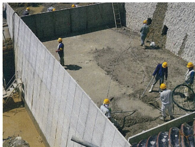
大型残存型枠の外部(平成24年8月31日撮影)
