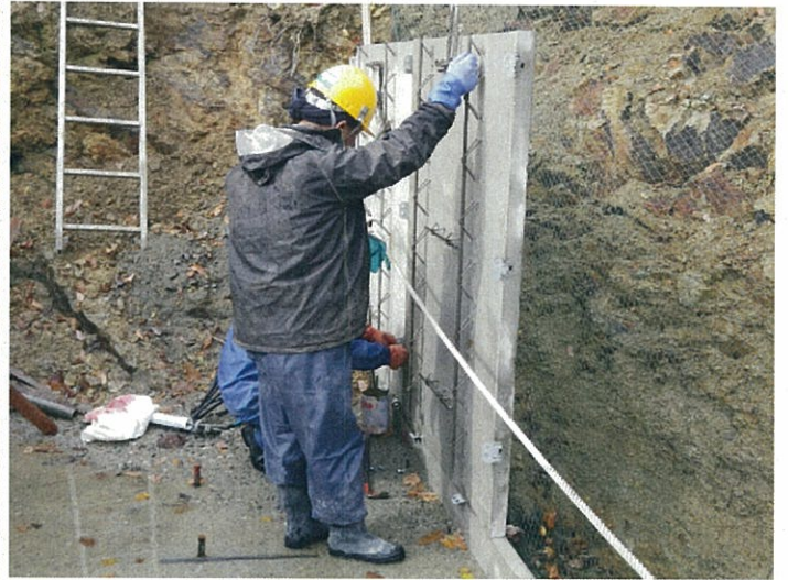
②パネル仮設置完了 (平成24年11月14日撮影)
