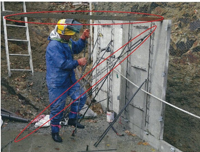
③サポート材、天端幅確保材によるパネル仮留め (平成24年11月14日撮影)
