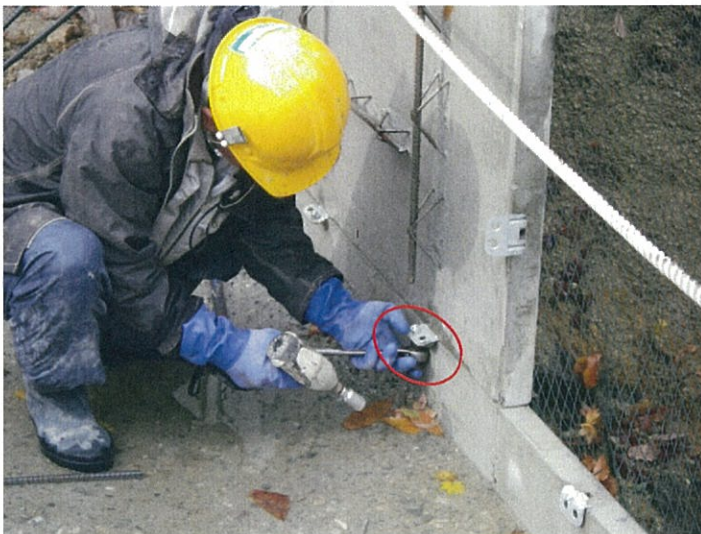
⑤ボルトによる固定 (平成24年11月14日撮影)
