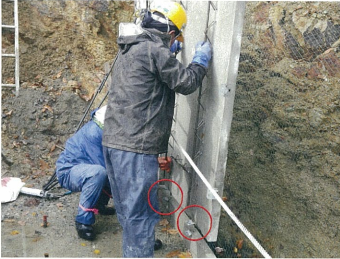
①クレーンによるパネル設置(上下パネル同士を調整用板バネによりジョイント)(平成24年11月14日撮影)
