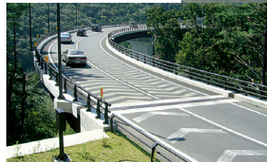
● 開通した郡山湖南線（三森工区）
