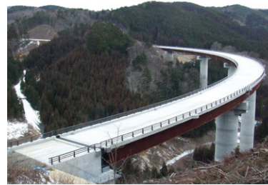
▲国道289号（荷路夫BP）貝泊大橋の施工状況
