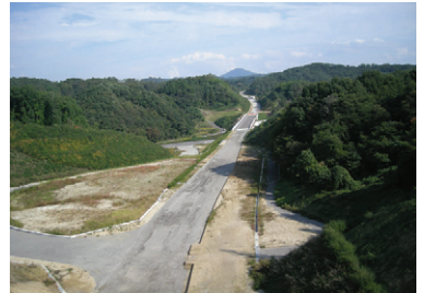
▲国道288号（三春西BP）の施工状況
