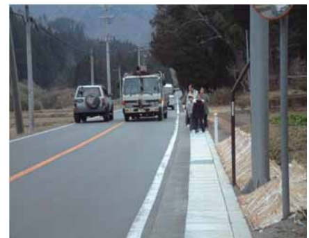
側溝蓋掛けによる歩行空間確保事例 (国道288号)
