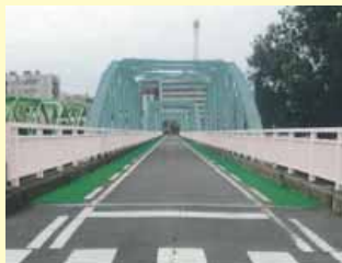
補修時に地域の意見を聞きながら橋梁の防護欄などを塗り替えて景観の向上を図る
