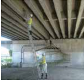
橋梁の定期点検実施状況
