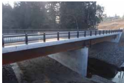
整備後（25t 車両対応）
