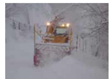
ロータリー除雪による拡幅除雪の状況
