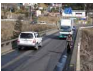
霊山松川線 逢隈橋(福島市)
