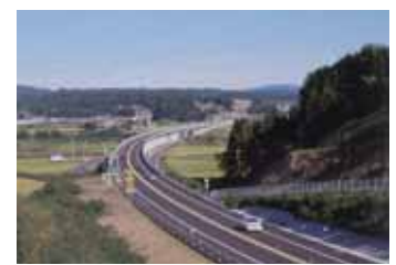
福島空港道路
