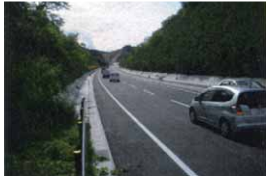
国道288号（三春西バイパス）
