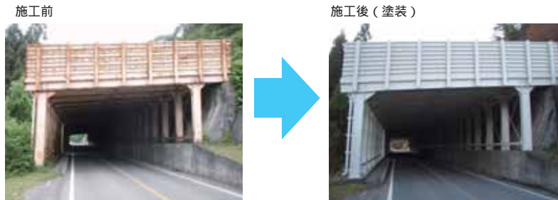
国道252号 本名スノーシェッド（金山町）
