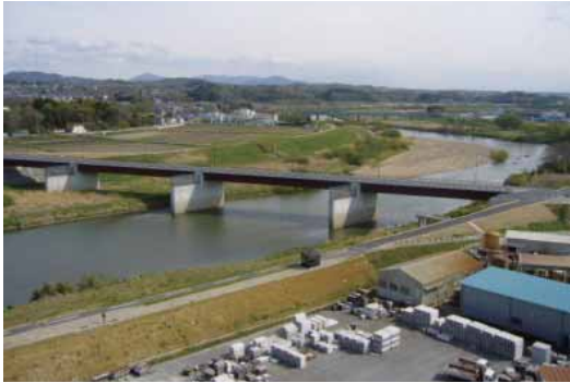
国道288号（富久山バイパス）の整備状況
