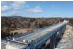
羽黒川橋双葉町山田地区
