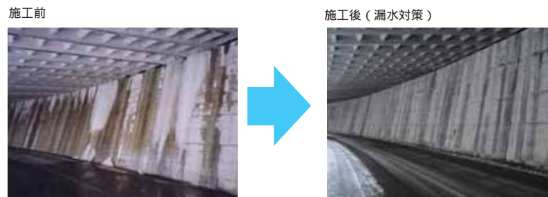
国道352号 小豆温泉スノーシェッド（南会津町）
