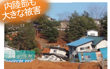
家屋被害の状況 (福島市伏拝地内)
