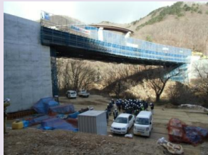
上部工施工中の様子
