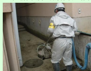
県営住宅五百淵団地の住宅除染(高圧洗浄除染)の様子
