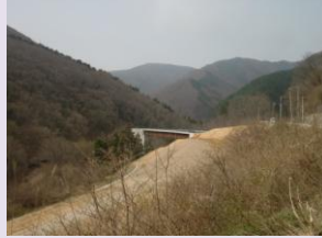
施工完了の様子
