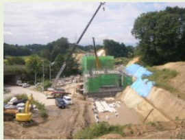
磐越自動車道を横断する橋梁を建設中
