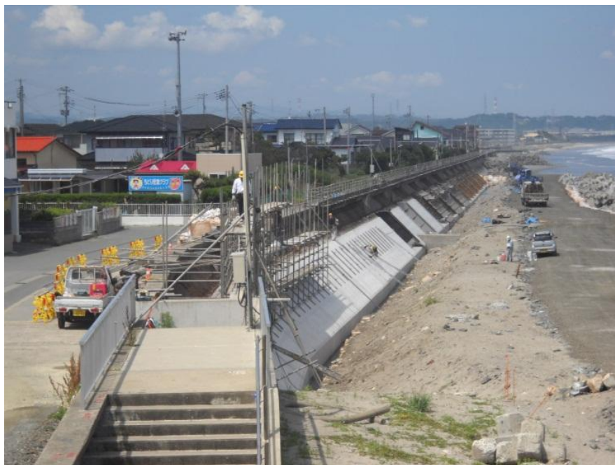
【工事中の写真】
