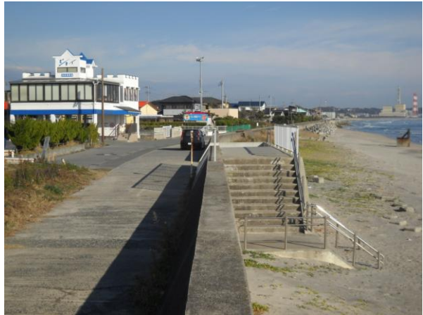
【工事前の写真】
