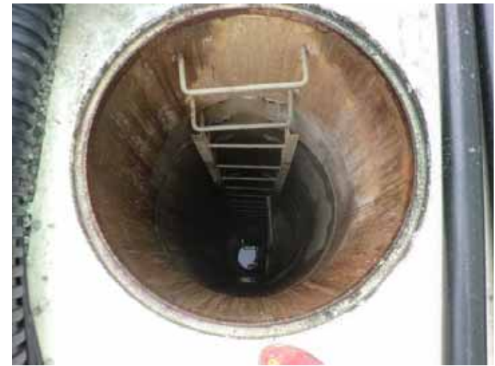
サブドレンピット内部
