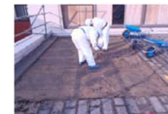
事務本館屋上コンクリート撤去
