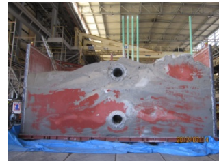
止水材注入後の積み上がり状況
