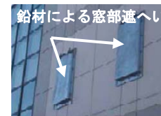
事務本館窓部鉛遮へい
