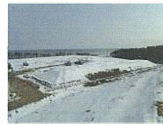
1槽目の状況 (1/16撮影)
