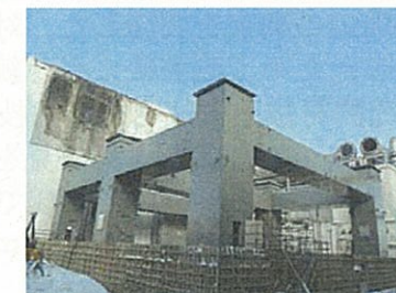
第1節部分鉄骨建方終了（1/14）
