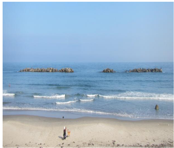
【工事前の状況】 H24. 8 撮影
