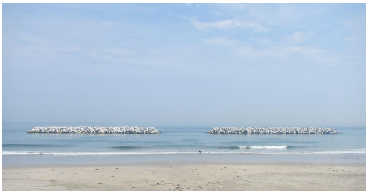
【完成写真】 H25. 7 撮影
