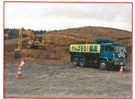
掘削工事開始
