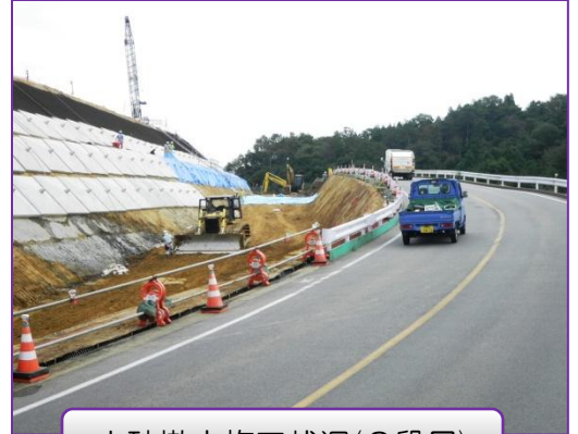
土砂撤去施工状況(2段目)
