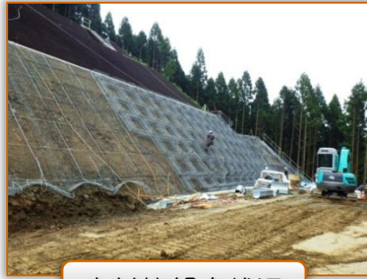
吹付砕組立状況
