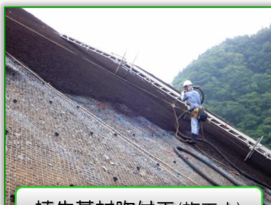
植生基材吹付工(施工中)
