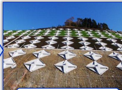
グラウンドアンカー工(完了)
