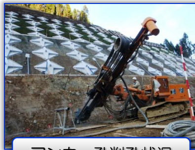
アンカー孔削孔状況
