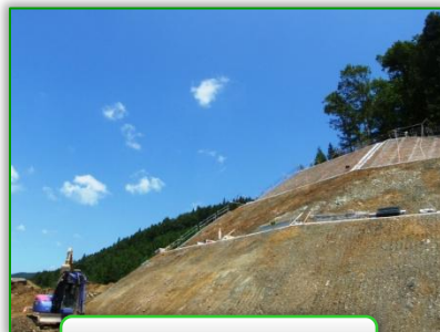
法面整形工(完了)
