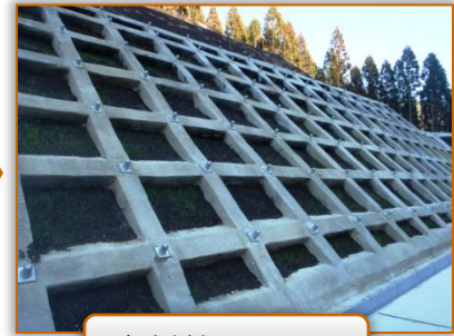
吹付砕工(完了)
