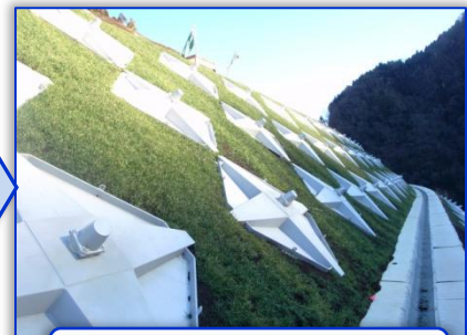
植生基材吹付工(完了)
