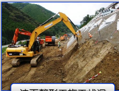
法面整形工施工状況
