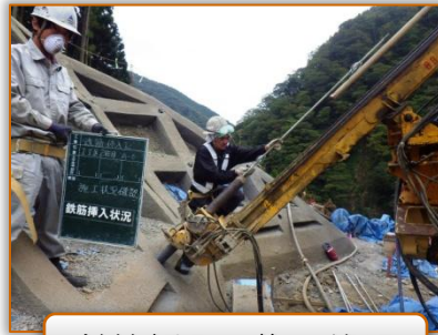
鉄筋挿入工施工状況
