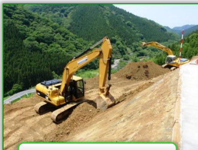
法面整形工(施工中)
