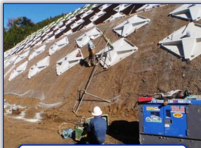
アンカー工緊張状況
