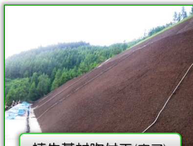
植生基材吹付工(完了)
