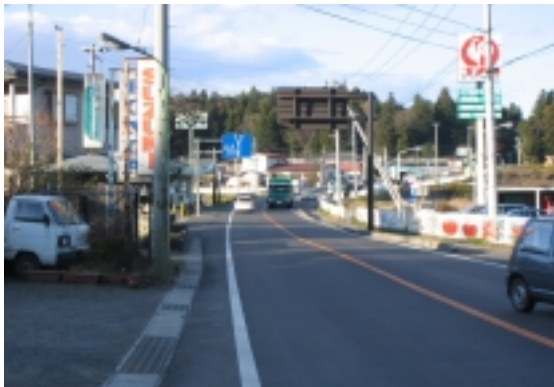
(主) 棚倉・矢吹線の住宅・商業地域の街並み
