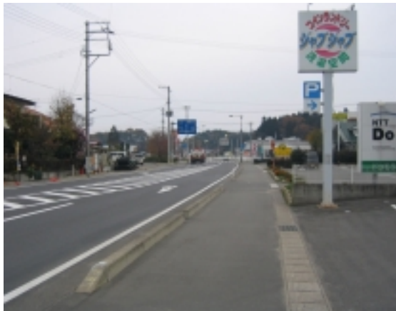
(主) 棚倉・矢吹線の住宅・商業地域の街並み
