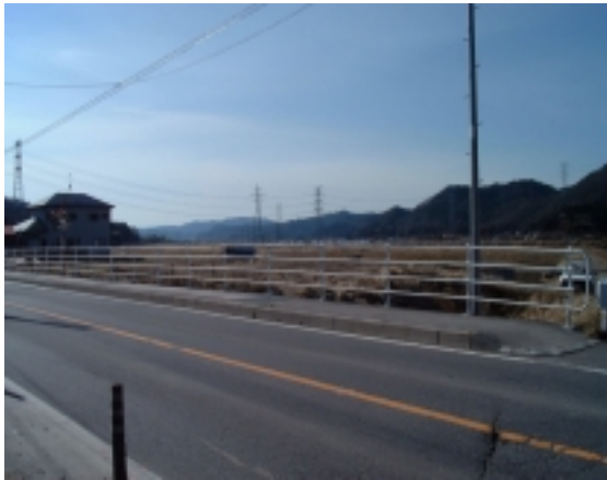
国道118号から望む久慈川のオープンスペースと、八溝山系
