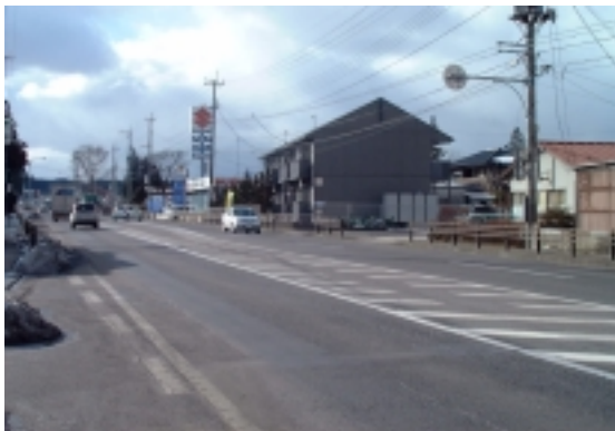
国道4号の景観に配慮された防護柵と住宅・商業地域の街並み
