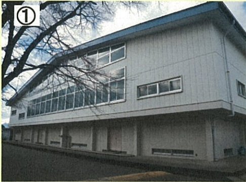
① 路線名：白河実業高校 事業名：白河実業高校災害復旧工事 事業所：白河市瀬戸原地内 工事説明：地震で被災した実習室や体育館の外壁・屋根の補修とともに耐震補強を行い、安全で良好な教育環境の提供を図ります。
