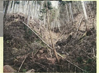
河川名：ボンケラノ沢 事業名：交付金事業 場所：東白川郡棚倉町大字大梅地内 工事説明：土石流による土砂災害を防止するため、砂防えん堤工の施工を進めています。
