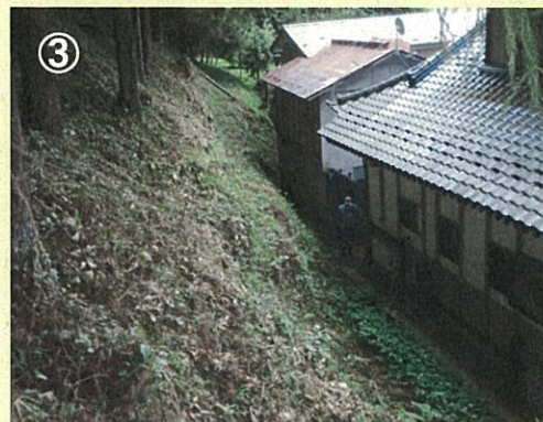
箇所名：岩下 事業名：交付金事業 場所：白河市表郷八幡字岩下地内 工事説明：斜面の崩壊等の危険性が懸念されるため、対策工事を実施します。また、人家だけでなく避難路である一般県道社田浅川線の保全も図ります。
