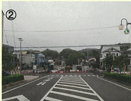
② 路線名：(都)白河駅白坂線 事業名：街路事業 事業所：白河市大工町地内 工事説明：「白河の顔となるシンボルロード」を形成する道路として、安全安心な歩行空間を確保することで、地域の歴史を生かしたまちなか観光を確立しながら、中心市街地の活性化に寄与します。
