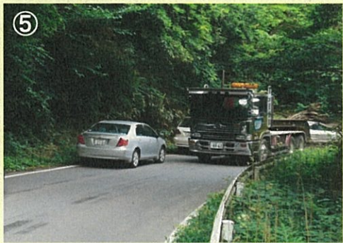
⑤ 路線名：国道289号 事業名：交付金事業 場所：東白川郡鯨川村大字渡瀬地内 工事説明：渡瀬バイパスは本県長期総合計画の中で七つの生活圏の連携を支える「南部軸」として位置づけられている重要路線であり、本道路の線形不良、幅員狭小区間の解消を図り、県南地方といわき地方を結ぶ広域連携促進を目的にバイパス整備を促進します。
