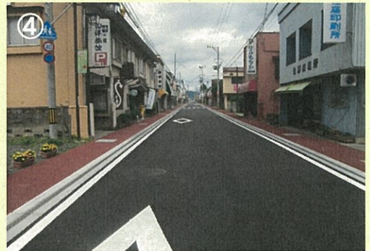
路線名：塙大津港線 事業名：交付金事業 場所：東白川郡塙町大字塙地内 工事説明：快適な道路空間づくりを進めるため、歩道の段差解消および歩道内の電柱移転を進めています。
