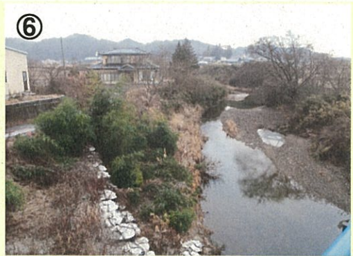
河川名：近津川 事業名：交付金事業 場所：東白川郡棚倉町大字下山本地内 工事説明：河道狭小による浸水被害を防止するため、河道拡幅や護岸工の施工を進めています。
