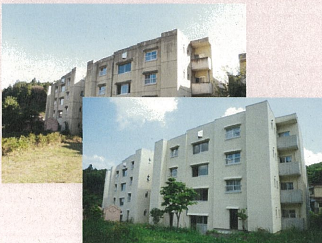
関川窪団地 1号棟外壁改修工事
