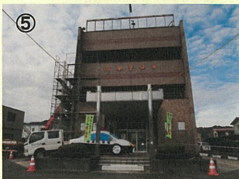
⑤ 路線名：棚倉警察署 事業名：棚倉警察署耐震改修・大規模改修工事 事業所：東白川郡棚倉町大字流地内 工事説明：庁舎の外壁補修や内部設備機器更新とともに耐震改修を行い、安全で良好な行政庁舎の提供を図ります。
