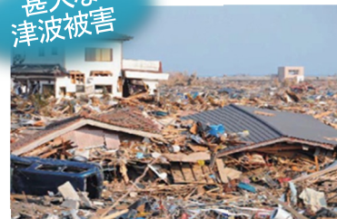
家屋被害の状況 (浪江町請戸地区)
