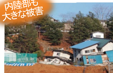
家屋被害の状況 (福島市伏拝地内)
