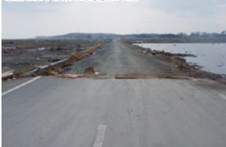
県道北泉小高線の応急復旧状況
