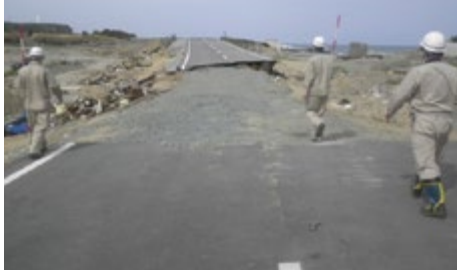
県道広野小高線の被災調査の状況
