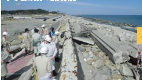
木崎地区海岸の被災状況
