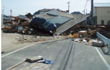
県道豊間四倉線の被災状況
