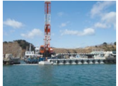
▲いわき市久之浜港の工事状況
