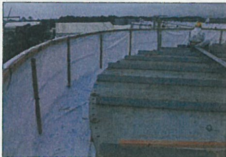
タンク歩廊部
