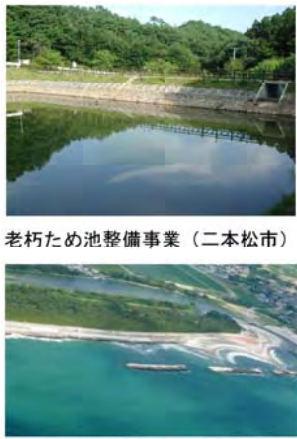
老朽ため池整備事業(二本松市) 海岸保全施設整備事業(南相馬市)
