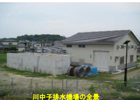
川中子排水機場の全景
