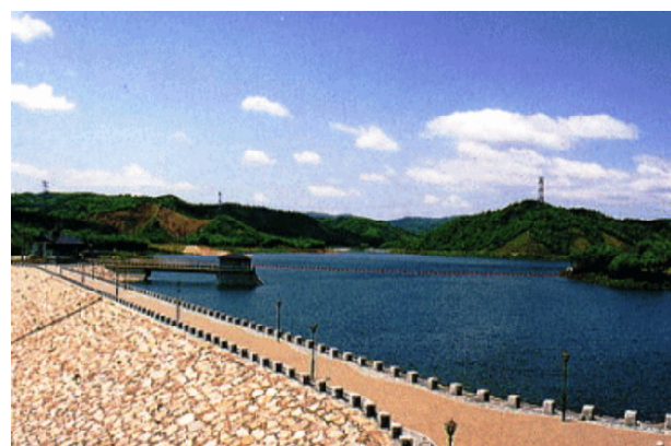
H24年度に事業実施予定の松ヶ房ダム
