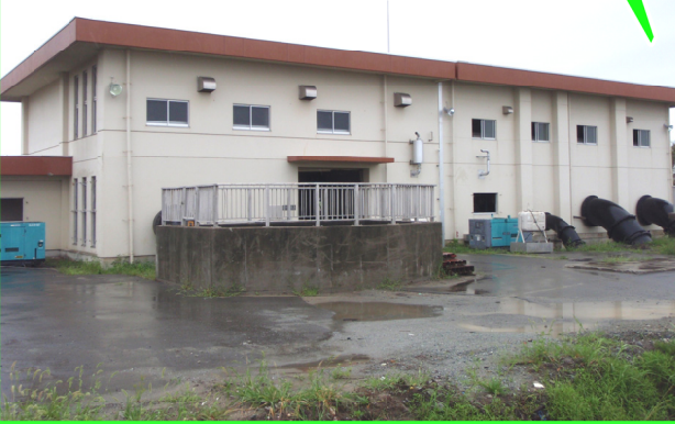
ガレキを撤去し、 復旧工事を行っている。
