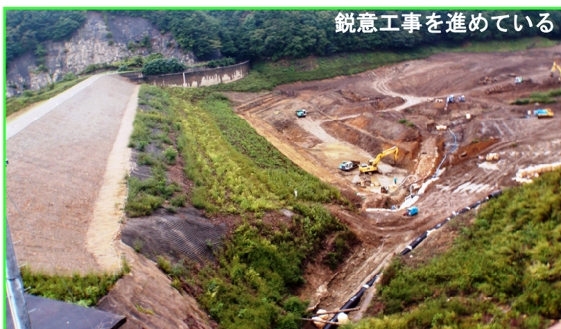
堤体天端の盛土が完了
