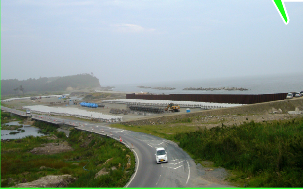
仮締切り工事を行い 本復旧工事を進めている。
