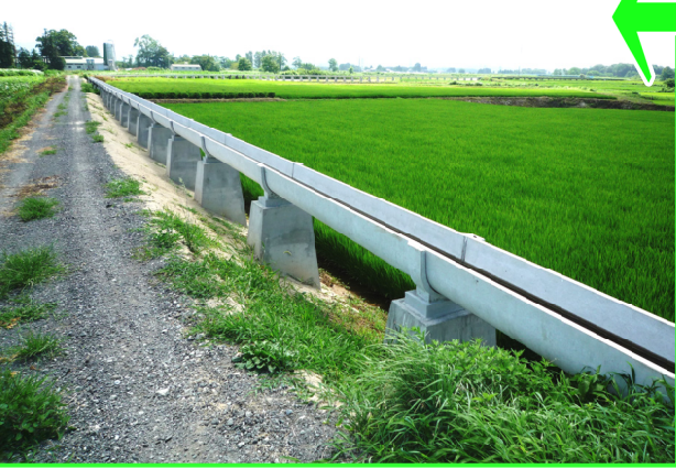
水路が復旧し、営農を再開
