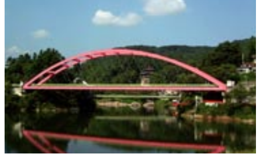
下路形式の橋梁
