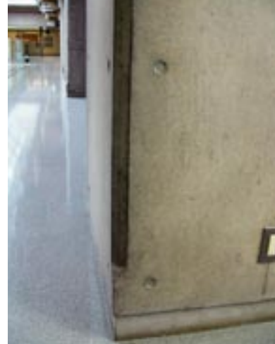
柱の角を面取りしている例 (郡山運転免許センター)
