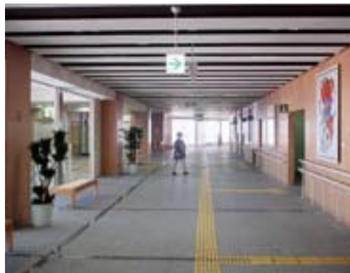
建物内の視覚障がい者誘導用ブロック (くまもと県民交流会館「バレア」)
