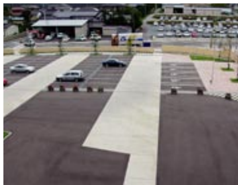
段差のない駐車スペース(新地町役場)
