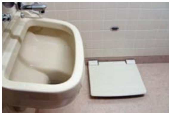
パウチなどの洗浄装置と靴を脱いで上げられる例
