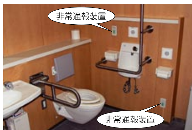
座ったときに手が届く位置と、倒れたときにも手が届く位置に設備された非常通報装置 (コラッセふくしま)
