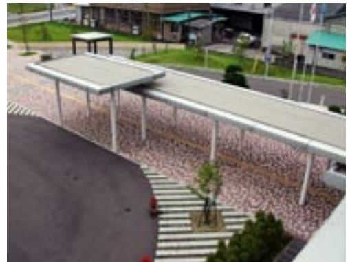
雨天時でも支障なく乗降できる車寄せ (新地町役場)
