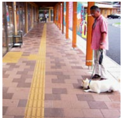
ブロックタイプの舗装材を敷設した通路 (道の駅はなわ)
