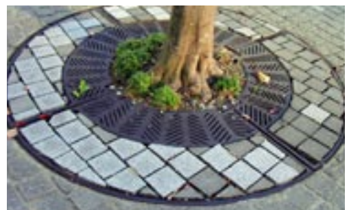
植樹柵の蓋は、かかとなどが落ちないデザインを選定しましょう
