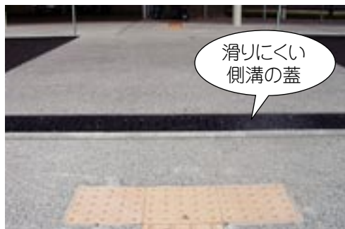
滑りにくく平坦なアプローチの例
