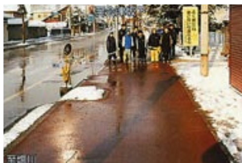
歩道に消融雪施設を設けた例
