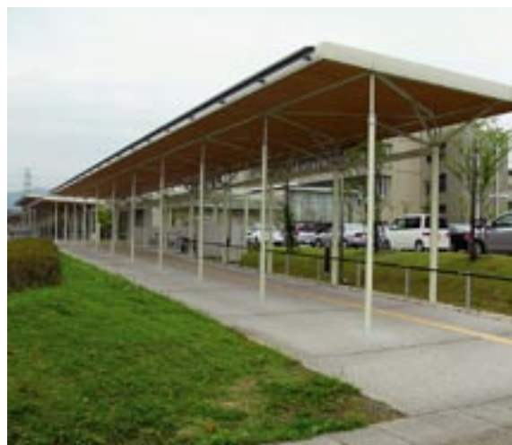
緩やかな勾配とし、屋根を設けた例 (県立大野病院)
