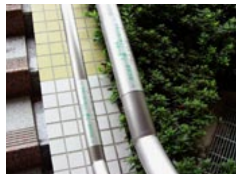
点字サインの例(郡山堂前地下歩道)
