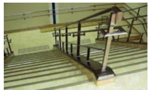
中間に手すりを設けた例 (うすい百貨店)
