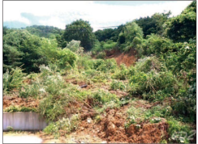
福島市大波地区の土砂崩れの様子
