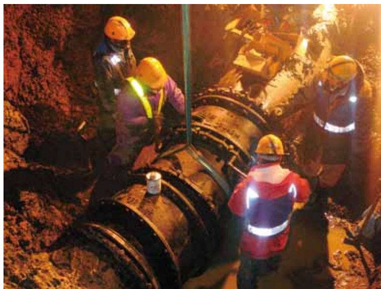
浄水場送水管漏水の修理
