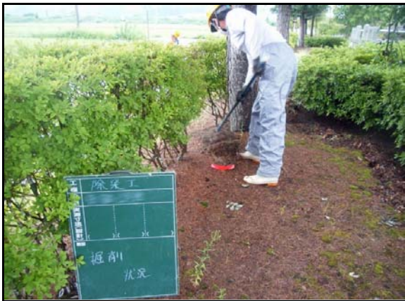
役場周辺除染(掘削状況)
