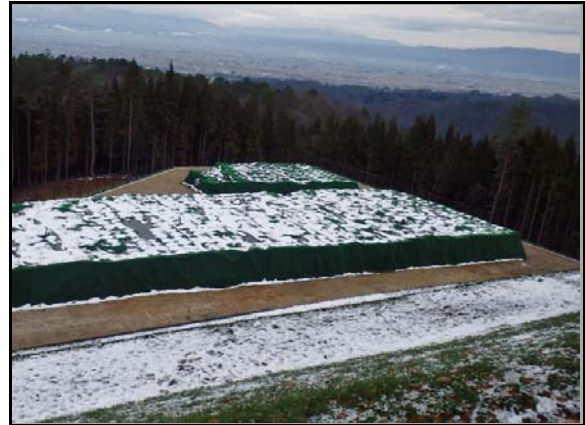
仮置場(切土法面上部より)
