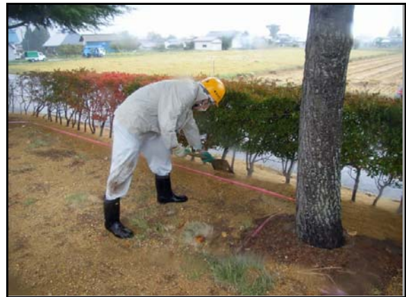
役場周辺除染(埋戻状況)
