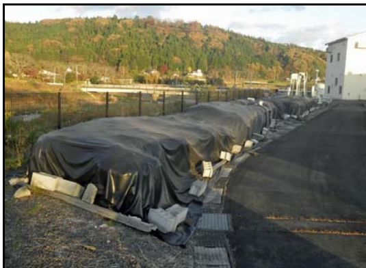
現場保管 (浅川浄化センター)
