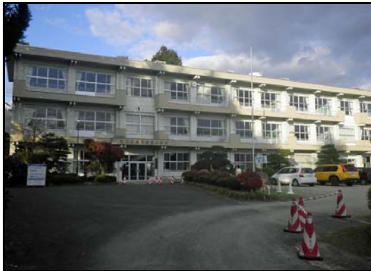
除染現場 (里白石小学校)
