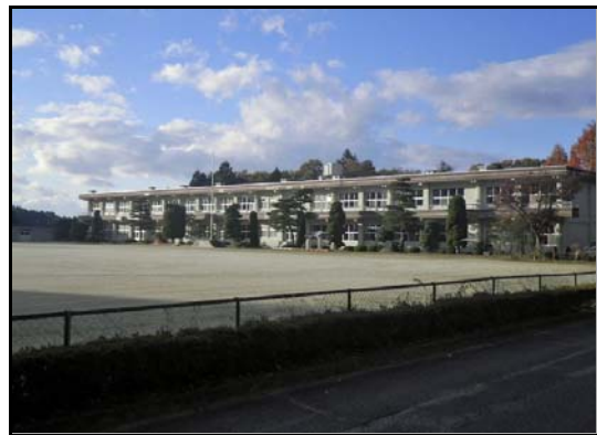
除染現場 (山白石小学校)
