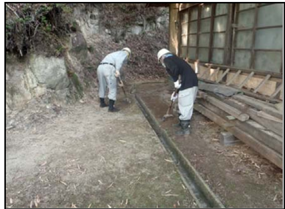
除染実施状況
