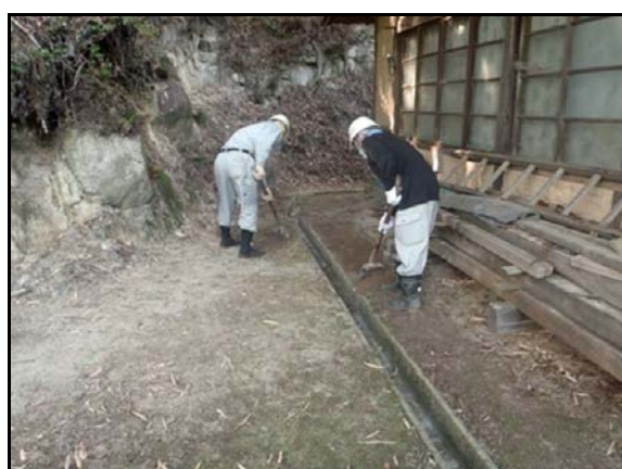
除染実施状況
