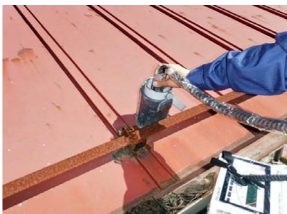
屋根の表面線量率測定
