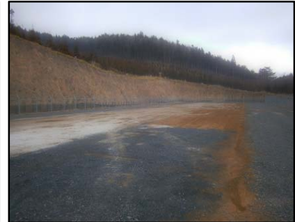
仮置場 (搬出済み)
