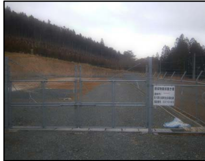
仮置場 (搬出済み)
