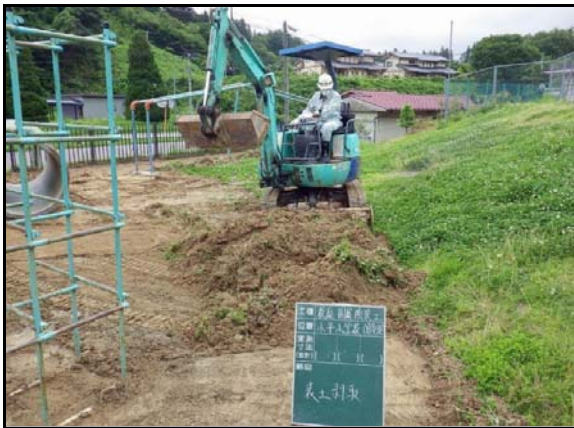
校庭除染工事表土剥取
