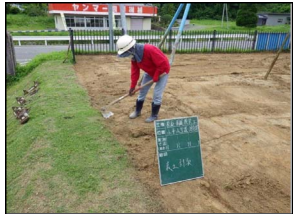
校庭除染工事表土剥取
