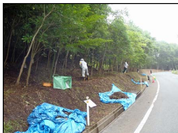
道路路肩除染作業 (H25当時)
