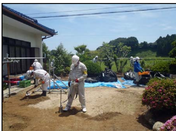
家屋除染作業 (H24当時)
