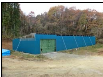
石川町仮置場
