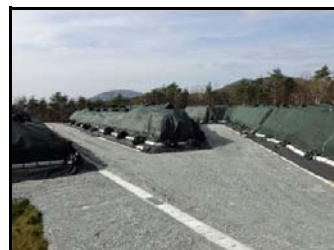
川前10区第3仮置場
