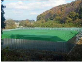
太田川仮置場
