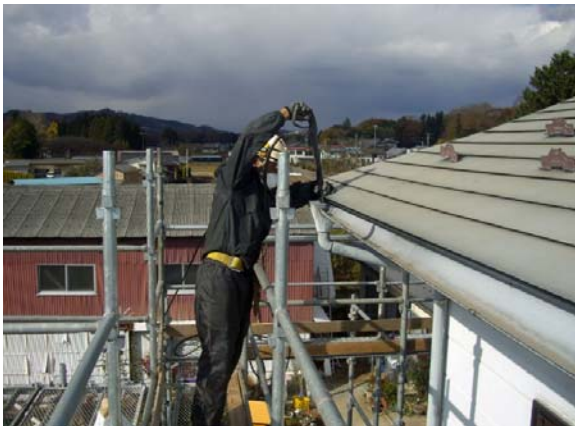
縦樋除染作業状況
