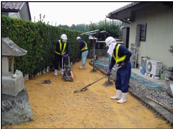
仁井田地区内住宅除染作業
