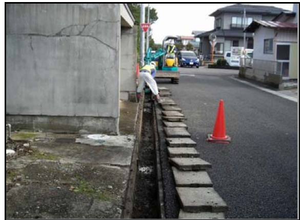
仁井田地区内側溝除染作業
