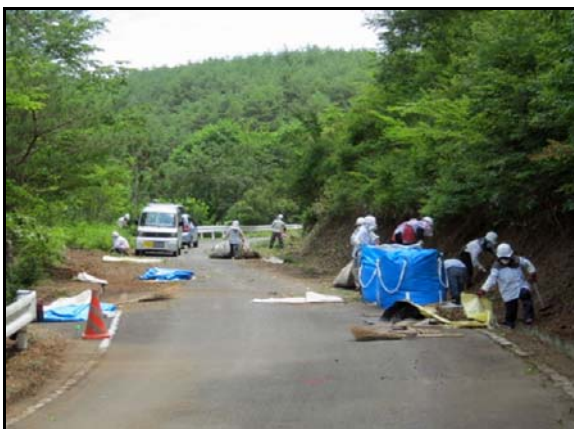
道路除染状況
