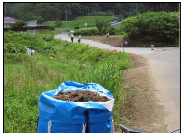
道路除染状況
