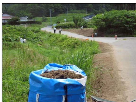
道路除染状況
