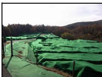
大津辺仮置場
