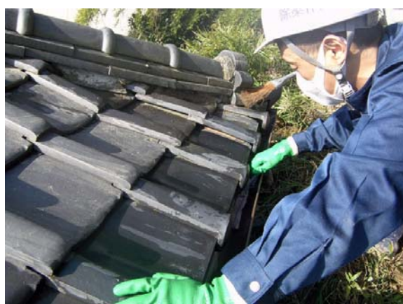
屋根拭き取り状況
