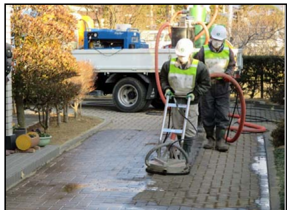
回収型高圧洗浄機による作業
