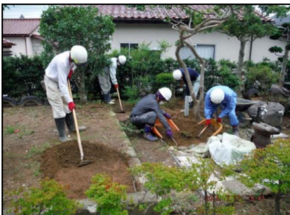
除染作業(表土除去作業)
