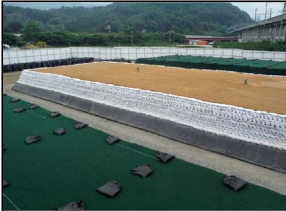
土のうで遮へいし、遮水シートで覆う前の状況
