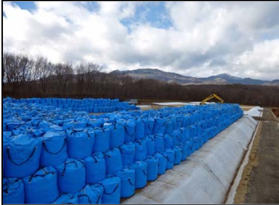
仮置場造成の様子
